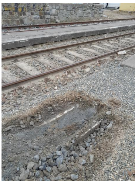
Kopaná sonda KS-7 (mezi kolejemi 3 a 1)
